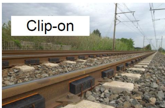
Figura nr 4: Amortizor de zgomot CORUS, aplicat
